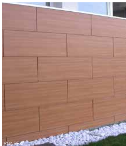
© INPEK Autorimessa - Bolzano
